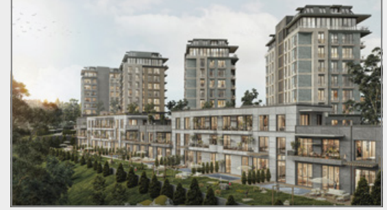
Kempinski Residences Balmumcu, inşaat aşamasındadır.
